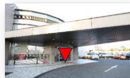
正面玄関ロータリー前
